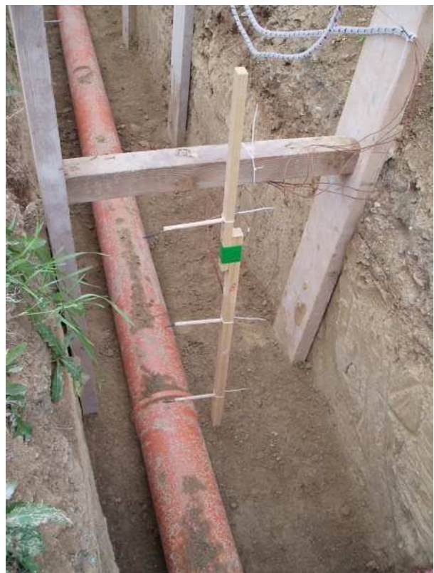
Obr. 3: Instalace teplotní sondy B.
