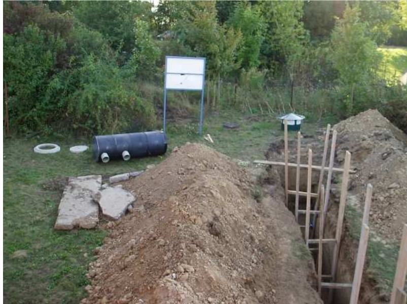
Obr. 1: Výkop pro uložení potrubí zemního výměníku tepla (ZVT).
