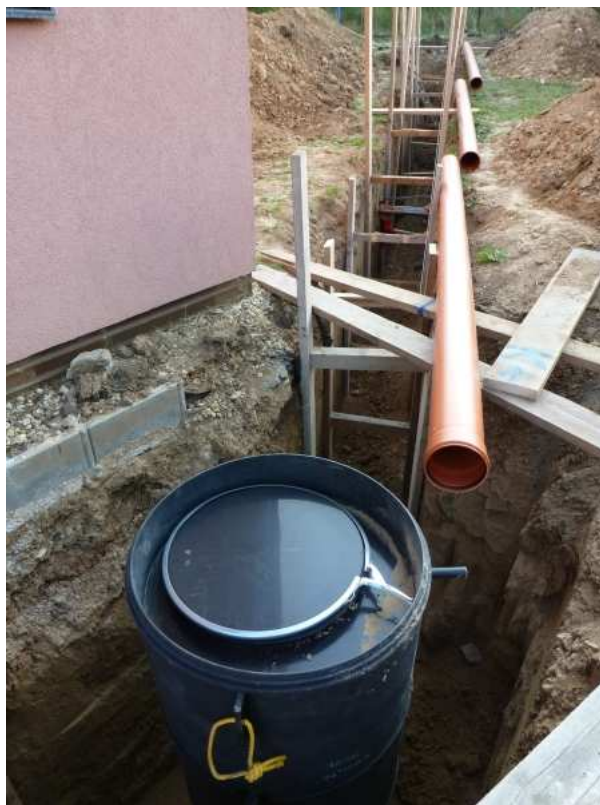
Obr. 2: Pokládka potrubí ZVT.
